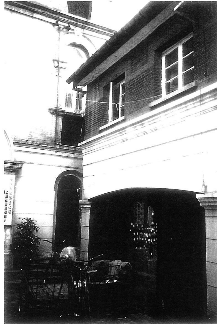
Abb. 67 Anbau nur etwa 1 m von Fassade entfernt
