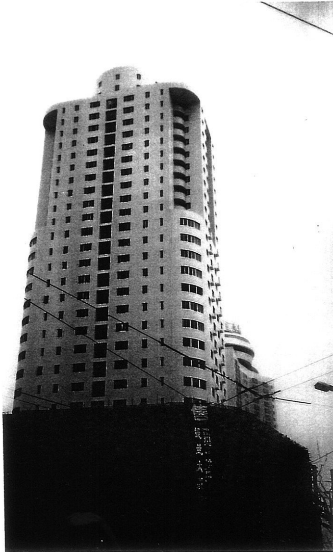
Abb. 48 Wohn- und Geschäftshochhaus Changyang Rd. / Haimen Rd.
