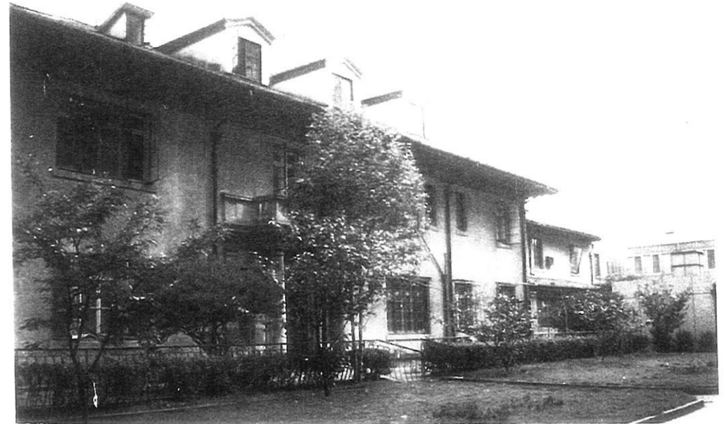
Abb. 16 Ehem. Gebäude des jüdischen Krankenhauses
